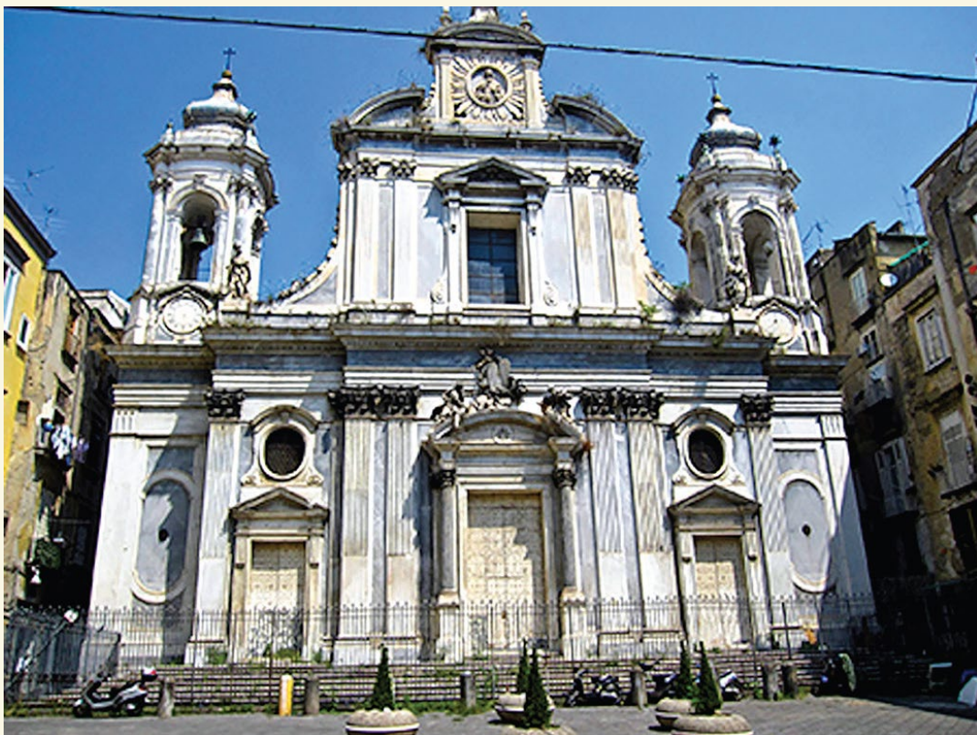
The façade of the Church of Santa Maria della Colonna, once the Conservatorio dei Poveri di Gesu Cristo (Naples)
